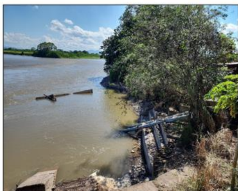
FIGURA N°01: TRAMO CRITICO DEL RIO HUALLAGA EN EL CUAL EROSIONA LA PARED DE TALUD DE RIBERA, DETERIORANDO ESTRUCTURAS DE ACCESO (RAMPAS DE PUERTOS).
